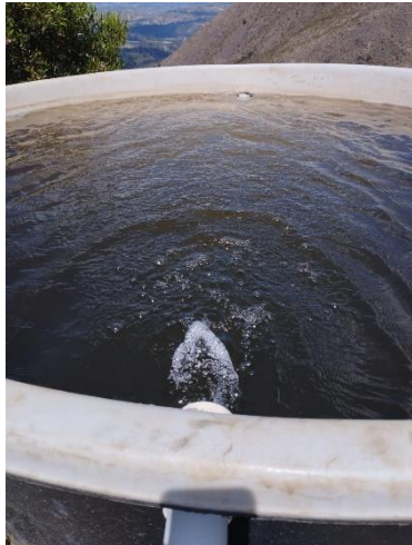
Imagen 8 Tanque 1 Provisión contra incendios
