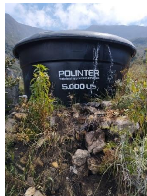
Imagen 7 Tanque 1 provisión contra incendios.
